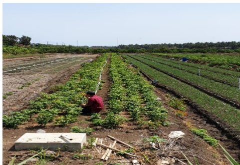
Gbr 7. Instalasi irigasi air dangkal sistem sprinkler
