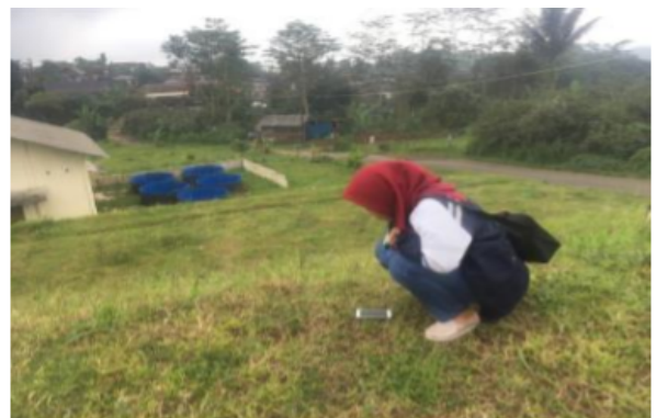
Gambar 2. Optimalisasi pengembangan potensi wisata Embung di Desa Harjodowo, Survey Spot Height area sekitar Embung Harjodowo untuk pembuatan kontur pada pembuatan peta situasi
