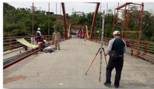
Gambar 3. Instalasi rambu ukur barcode di empat titik pengamatan
