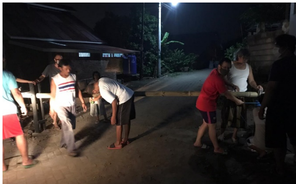
Gambar 6 Gotong Royong Warga Perumahan membangun portal
