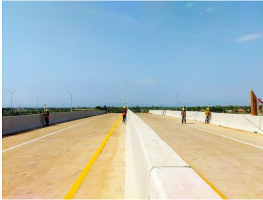
Gambar 2. Pengukuran penampang melintang jalan tol menggunakan metode GNSS secara RTK
